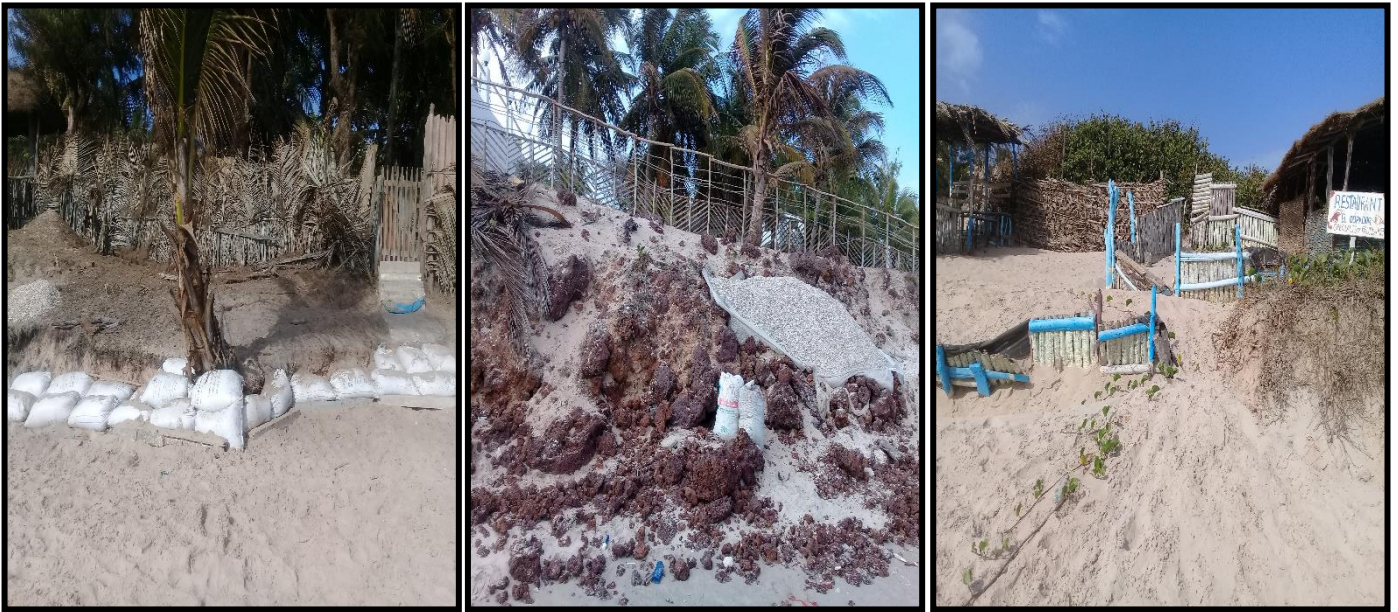
Image 16 : Stratégies d’adaptation à base de sacs de sable et de piquets en bois (à gauche : Mansa Lodge, au centre : hôtel les Hibiscus, à droite : restaurant Eldorado) Diatta, 2019.
