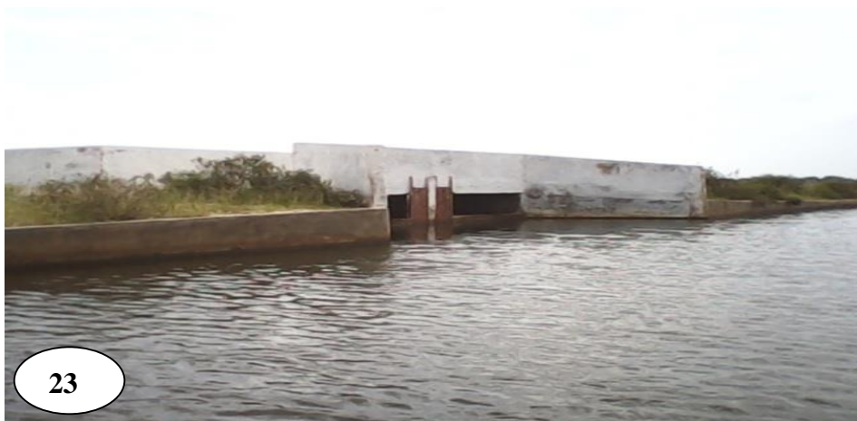
Photo n° 21, 22, 23 : Quelques digues construites dans la commune de Djilass (clichés Dia, Septembre 2016)
