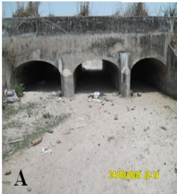
Photo2 : Ouvrage de gestion des eaux pluviale sur le point d'être obstrué par du sable à Tenghory Transgambienne (photo Coly, 14/03/ 2015).
