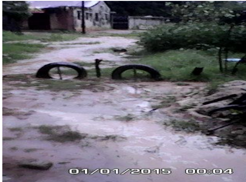
Photo 6 : Système utilisé par les populations pour bloquer les ordures, les débris et le sable dans le quartier de Tenghory Transgambienne 1 (photo Coly, le 16/08/2015).
