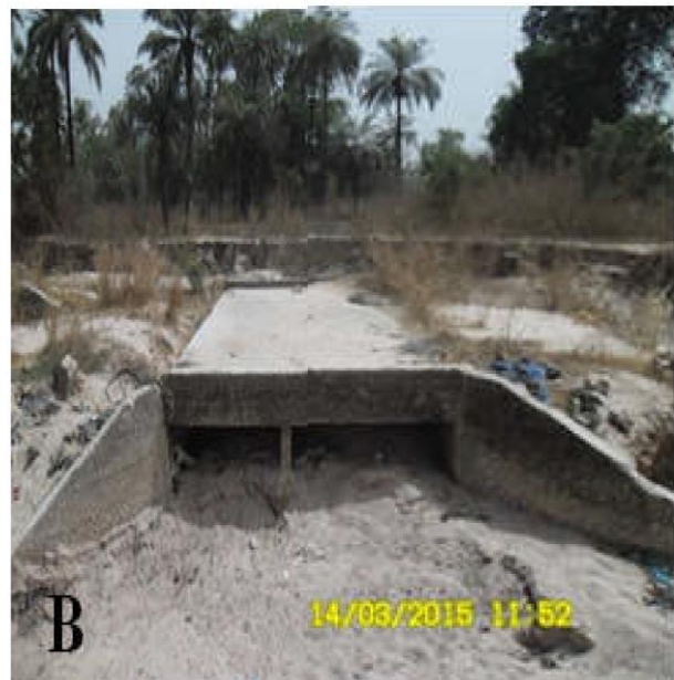
Photo2 : Ouvrage de gestion des eaux pluviale sur le point d'être obstrué par du sable à Tenghory Transgambienne (photo Coly, 14/03/ 2015).
