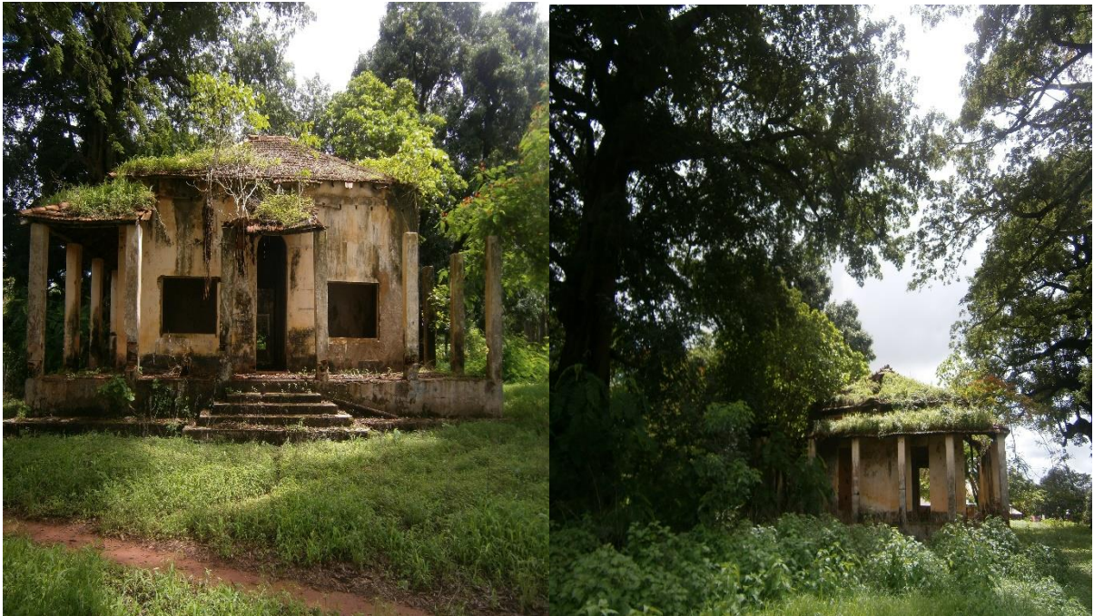
Figure 18: Ancien poste administratif sur l'île São João
