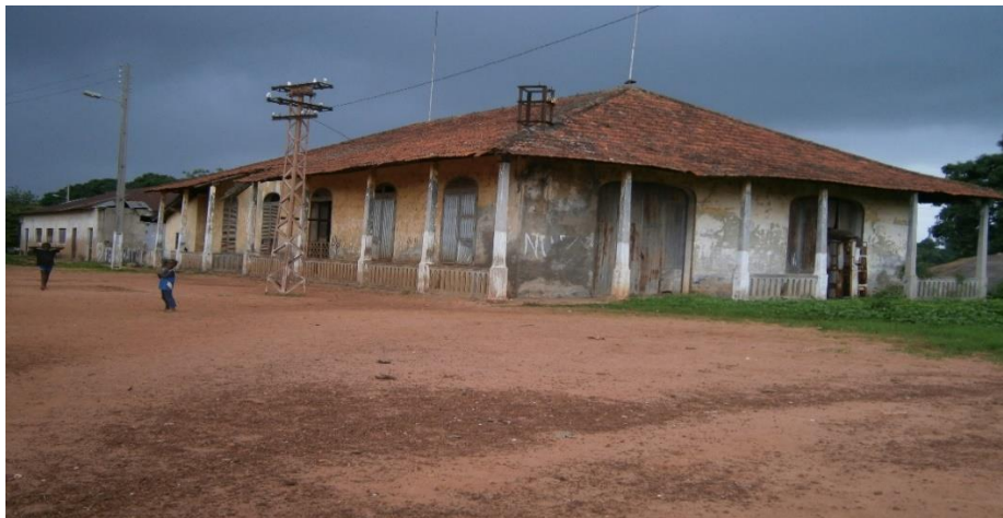
Figure 16 : Centrale électrique de Bolama
