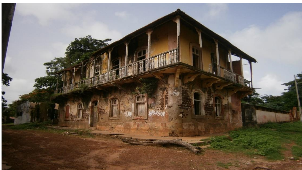
Figure 22 : Ancienne maison des pompiers de la Guinée portugaise
