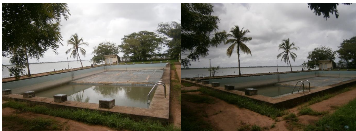
Figure 29 : Piscine Municipale de Bolama
