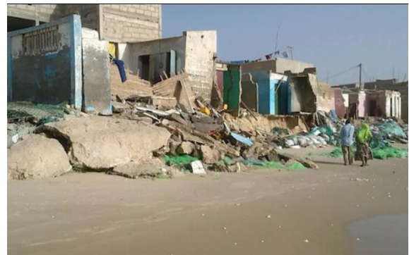
Photo : Maison détruite par l'avancée de la mer à Guet Ndar
