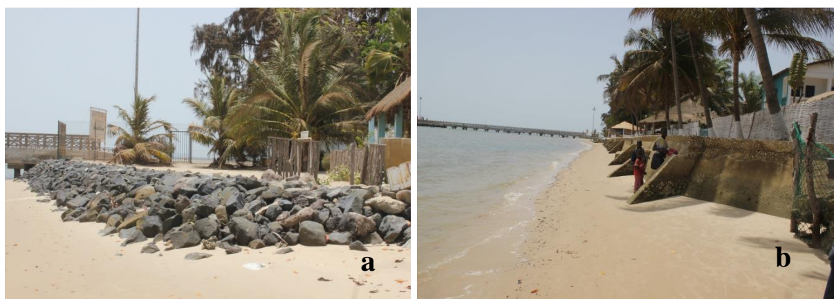
Photo 15 : Murs de protection des réceptifs à Carabane : (a) Campement Barracuda ; (b) Hôtel Carabane (Février 2018)
