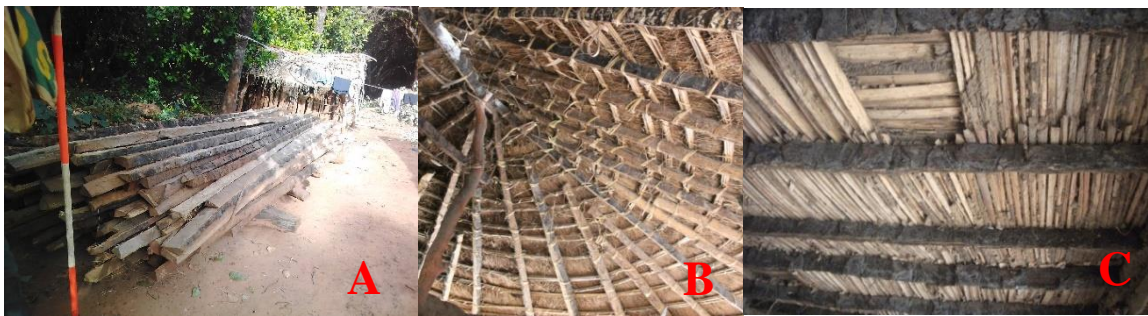
Figure 8 : Utilisation du stipe de Elaeis guineensis dans la construction : Chevrons (A), Charpente (B) et Plafond (C) (SAGNA, 2018)
