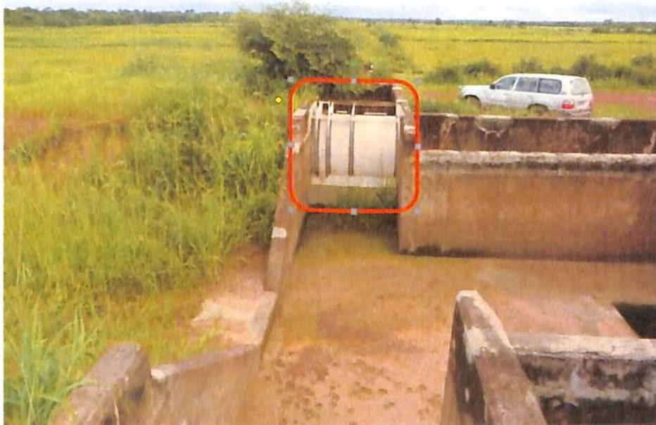
Figure 9: module à masque à la sortie du bassin de dissipation
