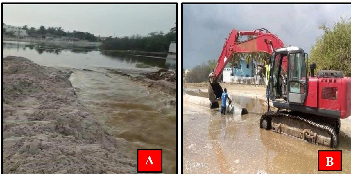
Photographies 27 : Ouverture d'une brèche sur le petit bras du marigot (A) et Installation des buses pour l'évacuation permanente des eaux (B) (Source : Tounkara 2020)
